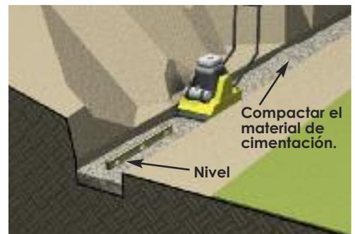
Colocar la hilada de replanteo, nivelar y compactar.
