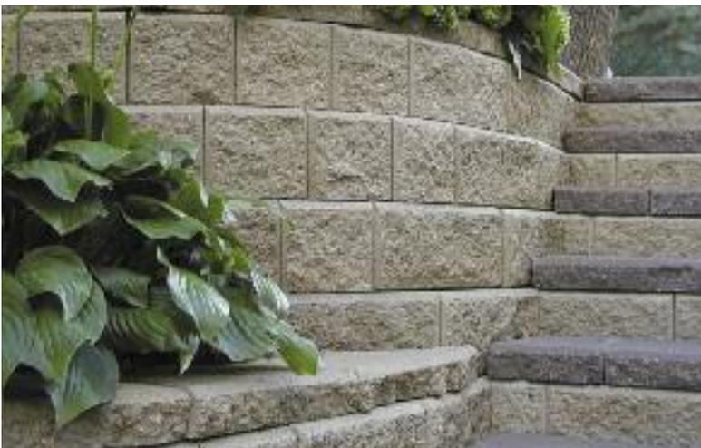
Para conseguir una curva más suave se puede cortar algún bloque o utilizar medios bloques, esto facilitará la construcción de la curva.
