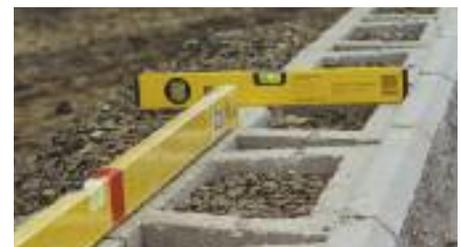
Con el diseño de núcleos huecos, Allan Block llega al sitio de trabajo pesando menos que un bloque sólido. Una vez que los núcleos son llenados, las unidades de Allan Block desarrollan la misma densidad que los bloques sólidos. Esta masa se combina con la inclinación para determinar la altura máxima del muro de gravedad.
