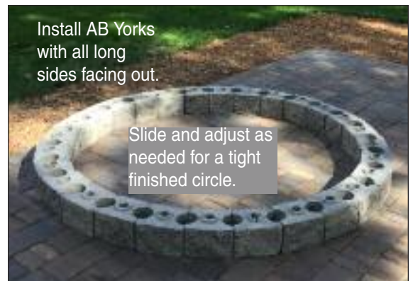
Install AB Yorks
